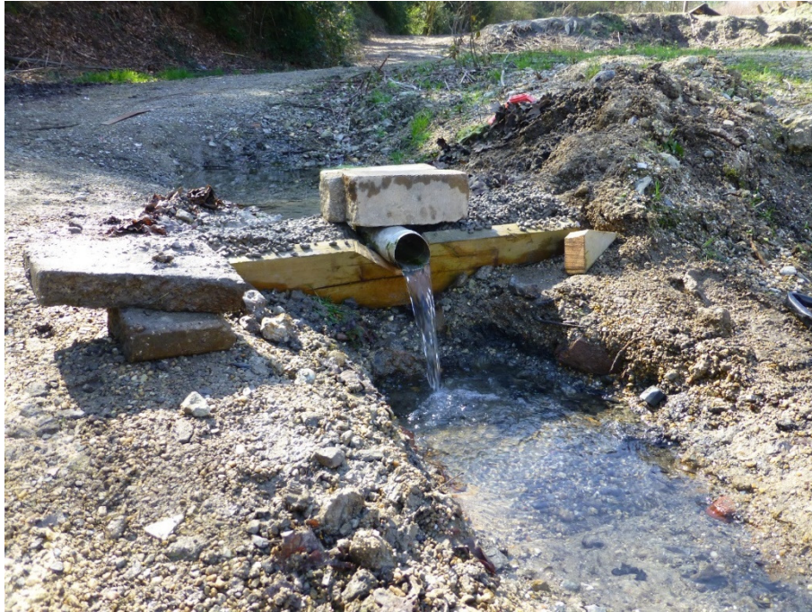
Figure 4 : source émergeant à la surface du revêtement existant
